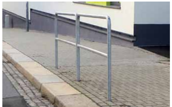
Abb. 41 Absperrbügel Edelstahl gebürstet
