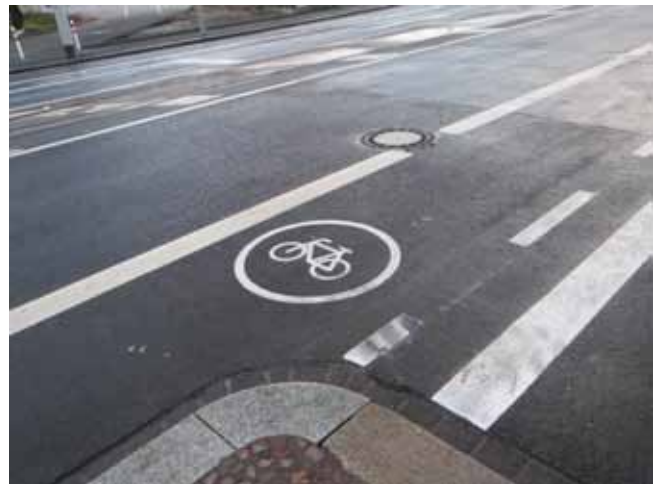
Abb. 18 Radwegemarkierung auf der Fahrbahn, Leipzig
