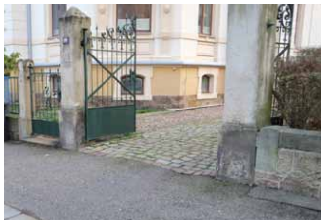
Abb. 131 schmiedeeisernes Tor und Einfahrt in Natursteinpflaster Schulstraße Frankenberg/Sa.
