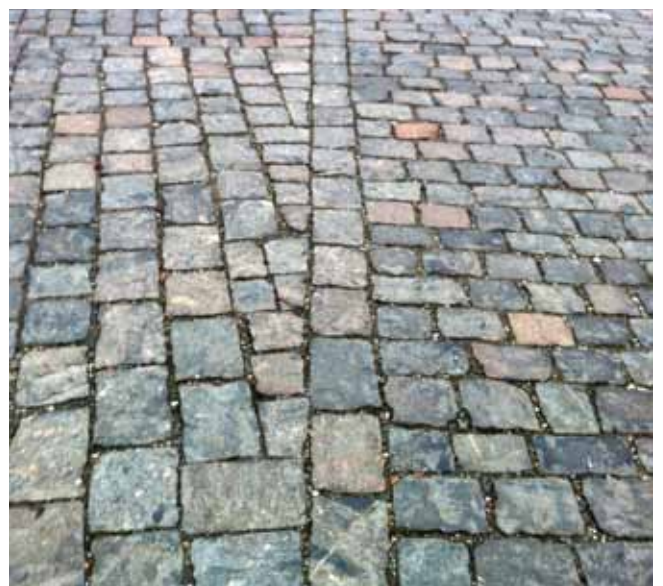
Abb. 46 Winkelausgleich bei Natursteinverlegung durch trapezförmige Steine, Markkleeberg
