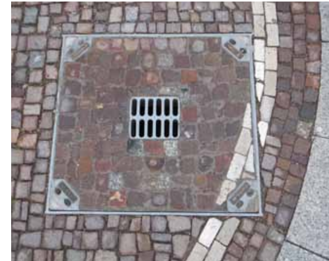
Abb. 64 Schachtdeckel rechteckig, ausgepflastert
