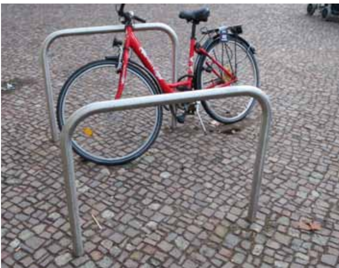
Abb. 126 Fahrradbügel, Leipziger Bügel, Edelstahl gebürstet
