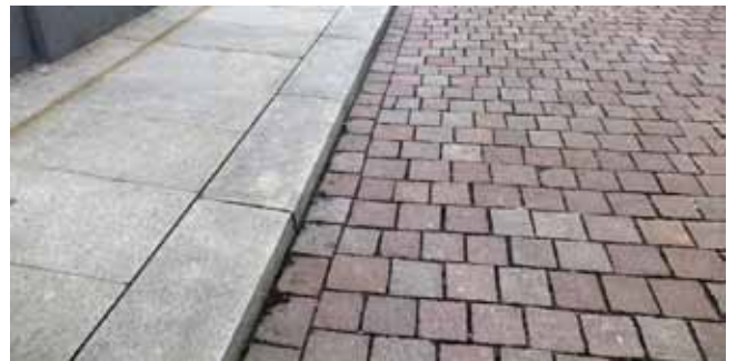
Abb. 45 B durchgängige Verlegung des Belages in Hauptbewegungsrichtung, Freiberg
