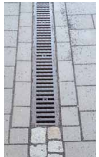
Abb. 104 Kastenrinne, Abdeckung Guss
