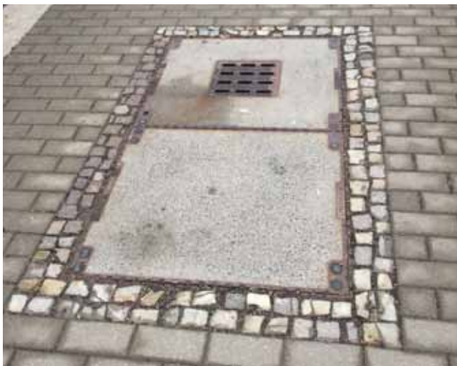
Abb. 102 Schachtdeckel rechteckig Beton
