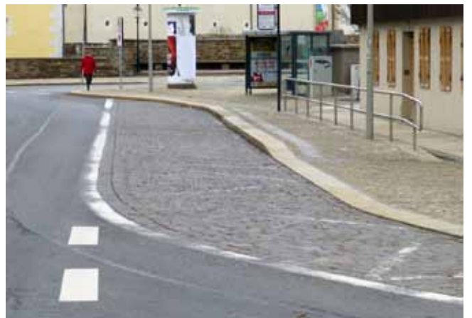
Abb. 52 Haltestelle im Fahrbereich mit deutlich abgesetztem Naturstein, Freiberg
