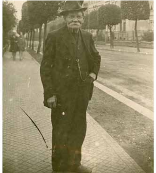
Abb. 80 Humboldtstraße um 1920 Frankenberg/Sa., diagonal verlegtes Klinkerpflaster
