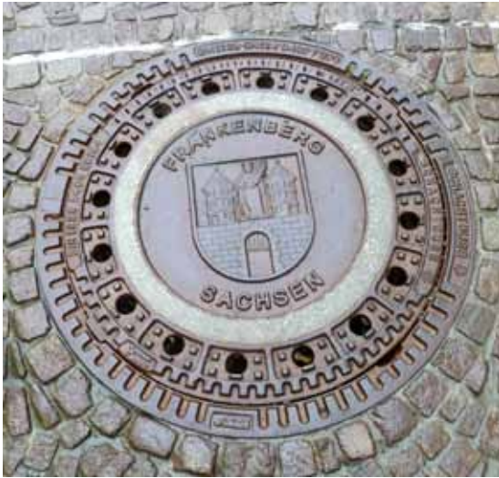
Abb. 121 Schachtdeckel mit Wappen, Guss
