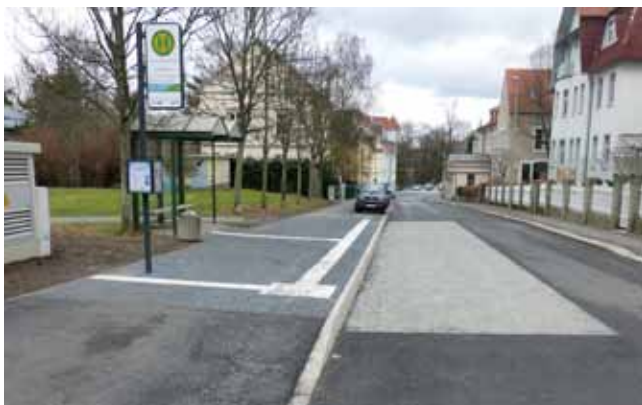
Abb. 7 barrierefreie Bushaltestelle mit Busbord, taktilem und visuellem Leitsystem und Bordabsenkung an der Überquerung, Freiberg
