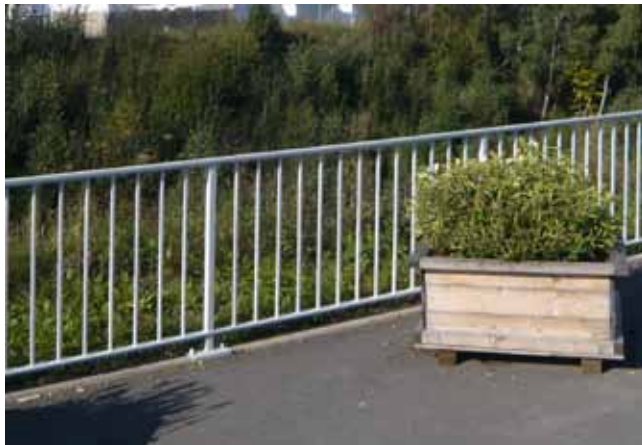
Abb. 38 Geländer schlicht für Geh- und Radweg, pulverbeschichtet in RAL- oder DB-Farbe
