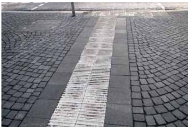
Abb. 14 Bodenindikatoren (Rippenplatte Beton), Leipzig
