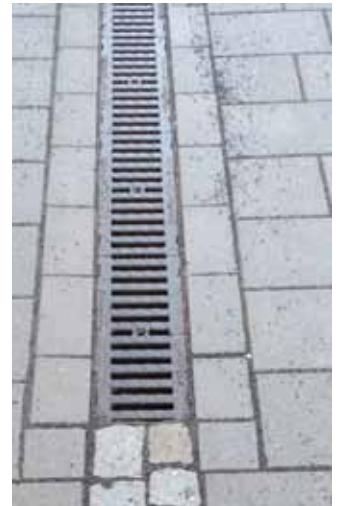
Abb. 125 Kastenrinne, Abdeckung Guss
