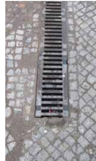
Abb. 63 Kastenrinne, Abdeckung Guss
