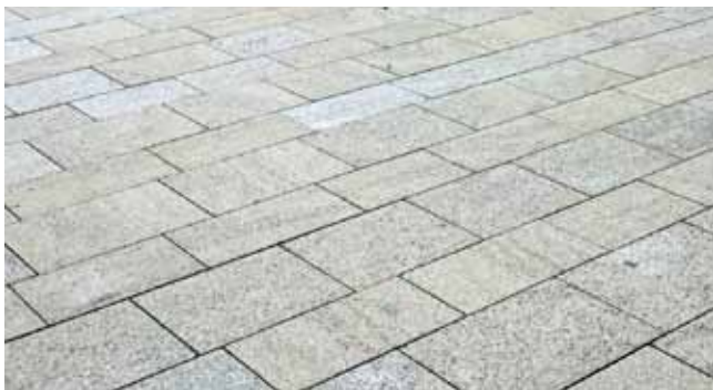
Abb. 44 Vermeidung von Kreuzfugen im Belag, Betonsteine mit Minifase in Gehwegbereichen, Leipzig
