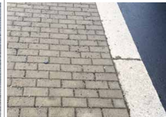
Gehweg Betonsteinpflaster grau Rechteckpflaster 10x20cm, halbsteinig versetzt quer zur Gehrichtung
