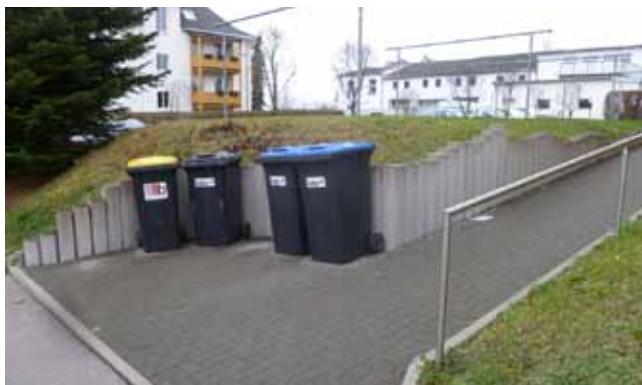
Abb. 132 störender Müllplatz direkt am Gehweg, Frankenberg/Sa.
