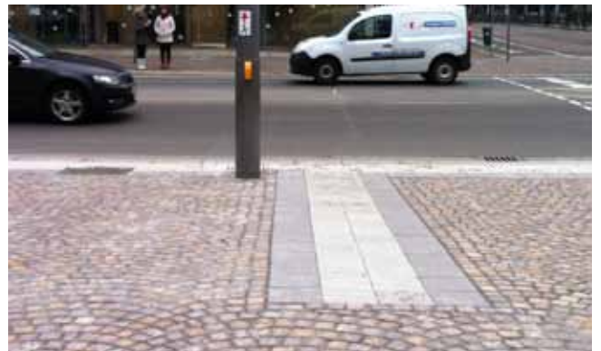
Abb. 15 Bodenindikatoren (Rippenplatte Naturstein), Leipzig
