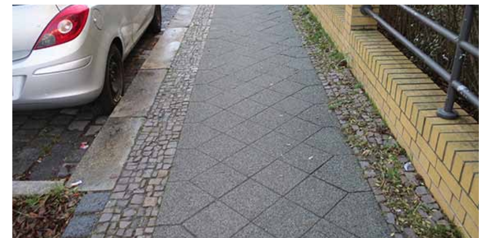
Abb. 84 Gehweg in Diagonalpflaster mit Bischofsmützen, Leipzig
