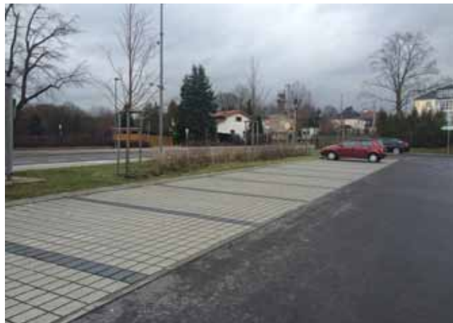
Abb. 36 Parkplatz, Bildungszentrum Frankenberg/Sa.
