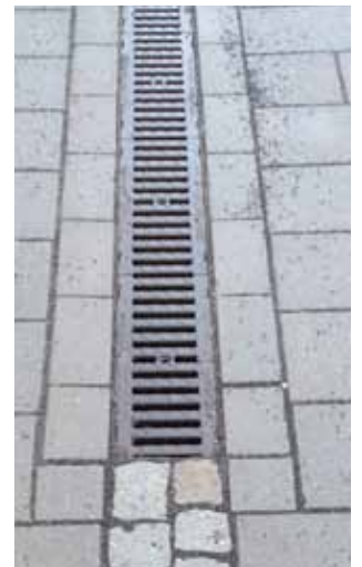
Abb. 89 Kastenrinne, Abdeckung Guss
