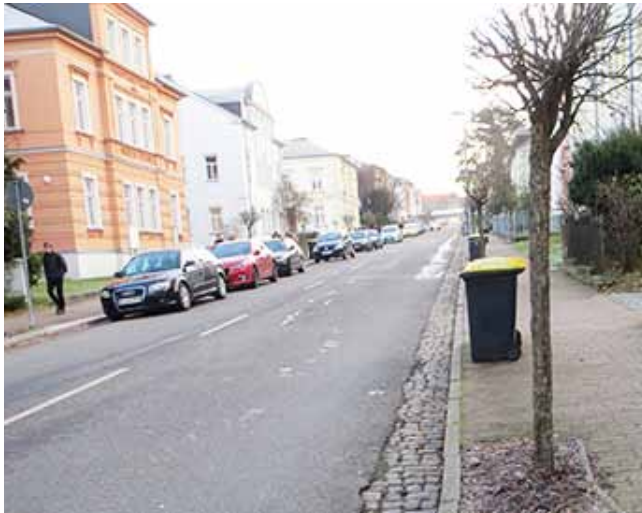
Abb. 78 Humboldtstraße Frankenberg/Sa.: historisches Kleinsteinpflaster als Rinne, Granitborde
