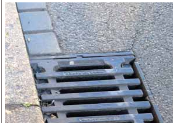
Bord/Rinne Bord Naturstein Granit grau, 15cm breit, Bordhöhe 3cm oder 8cm, Rinne aus Betonsteinpflaster 10x10cm, grau, Einzeiler
