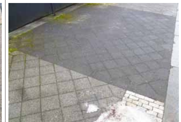
Gehwegüberfahrt Betonsteinpflaster anthrazit mit Natursteinvorsatz, quadratisches Format 16x16 diagonal verlegt mit Bischofsmützen
