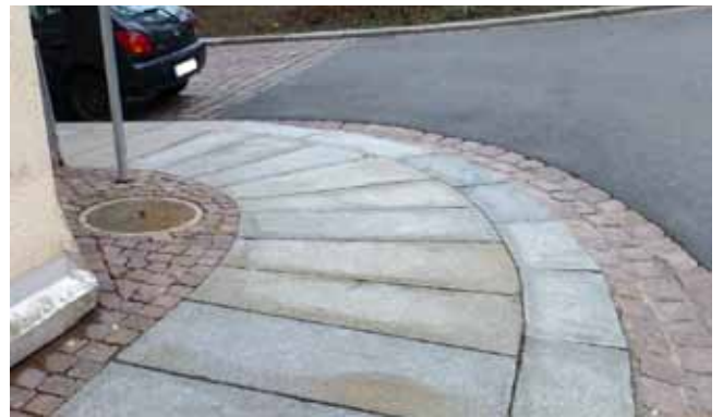
Abb. 45 A durchgängige Verlegung des Belages in Hauptbewegungsrichtung auch in Eckbereichen, Mittweida
