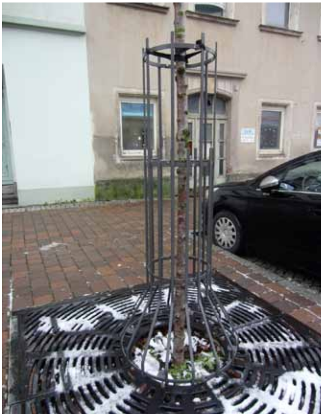
Abb. 22 geschlossene Baumscheibe mit Baumschutzgitter, Frankenberg/Sa.
