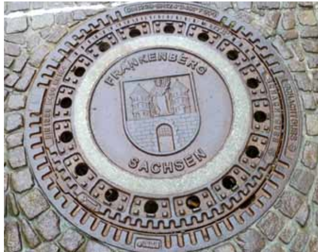
Abb. 61 Schachtdeckel mit Wappen, Guss
