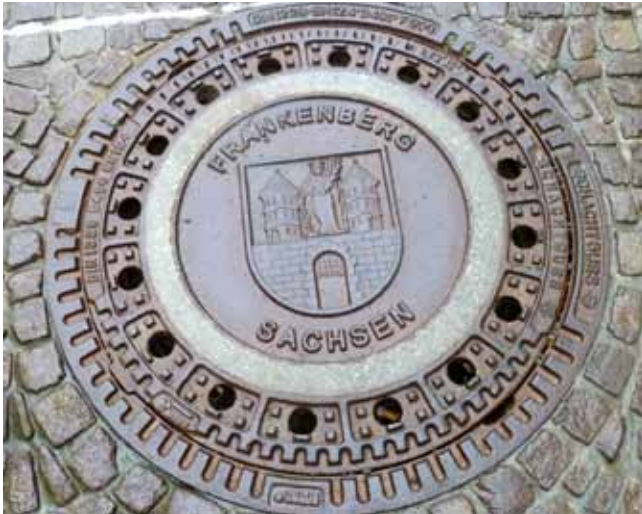
Abb. 85 Schachtdeckel mit Wappen, Guss
