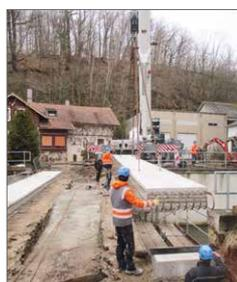
bauten der Brücke wurden bis auf den intakten Sandsteinbogen abgetragen. Am 29.01.2025 wurden durch einen 200-Tonnen-Kran zwei jeweils 18 Tonnen schwere Betonhalbfertigteile eingehoben. Aufgrund der sehr beengten Verhältnisse vor Ort musste das Team aus Bauarbeitern und Kranführer Millimeterarbeit leisten. Mit der heutigen Montage ist ein wichtiger Meilenstein bei der Sanierung der Brücke gelungen, auf den die Nachfolgearbeiten aufbauen.
