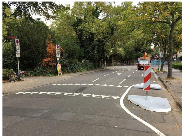
Links: Bordsteinklebetechnik: Flachborde und Inselkopf. (Quelle: Meudt Betonsteinwerk) Rechts: „Gehweg Nase“ bzw. vorgezogener Seitenraum (Quelle: Lüft Verkehrstechnik)
