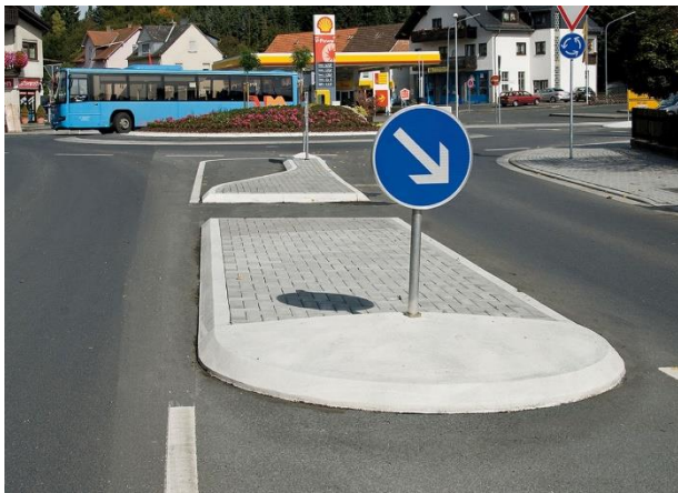
Links: Bordsteinklebetechnik: Flachborde und Inselkopf. (Quelle: Meudt Betonsteinwerk) Rechts: „Gehweg Nase“ bzw. vorgezogener Seitenraum (Quelle: Lüft Verkehrstechnik)
