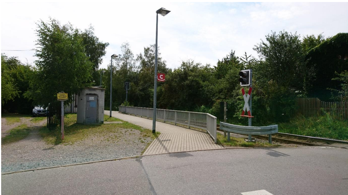
Haltepunkt Dittersbach, im Vordergrund Straße Zum Bahnhof mit Bahnübergang
